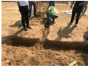
图 4 底基层应变计与压力计
