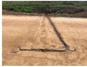
图 5 下基层应变计
