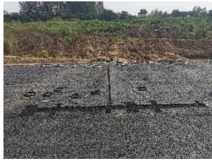
图 7 下面层应变计与压力计
